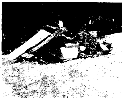
Figura 19 – Entulhos nas oficinas do CIR.
